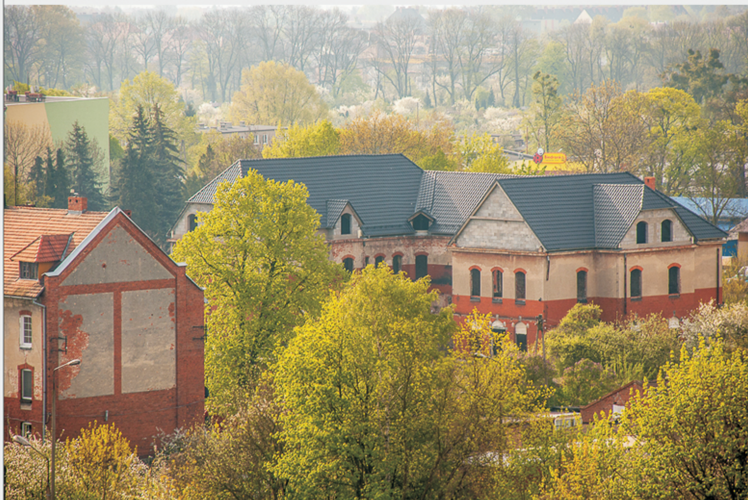
Widok na elewację od strony północno-zachodniej
